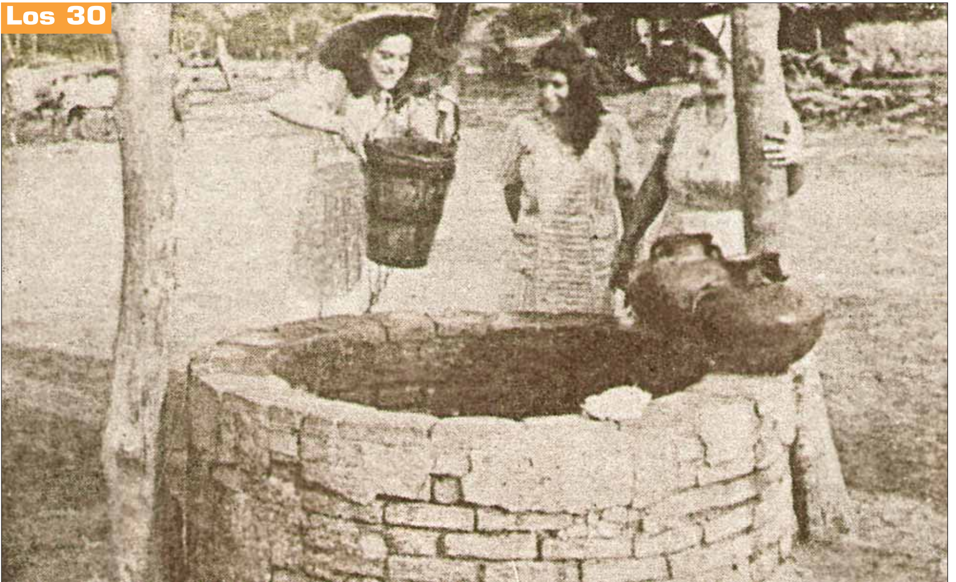
El tradicional aljibe en pleno uso. Es un depósito destinado a guardar agua potable, procedente de la lluvia recogida de los tejados de las casas, habitualmente, que se conduce mediante canalizaciones. Suele estar construido con ladrillos unidos con argamasa.
