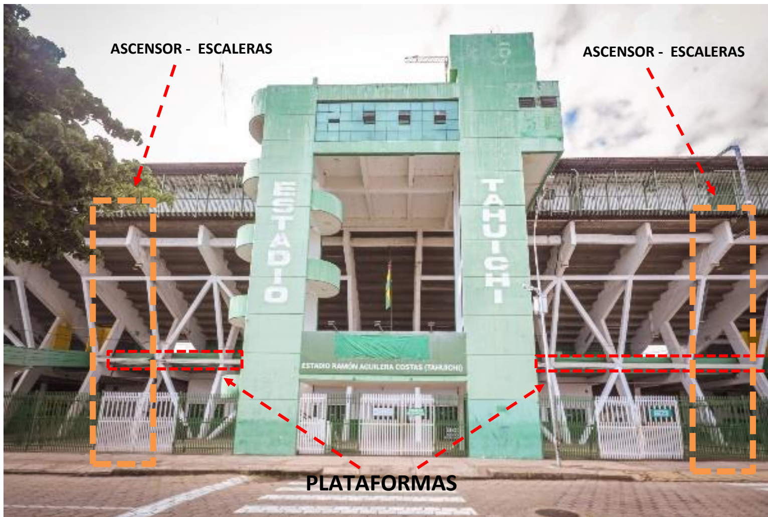
ESTADO ACTUAL FACHADA PRINCIPAL CALLE SOLIZ OLGUIN
